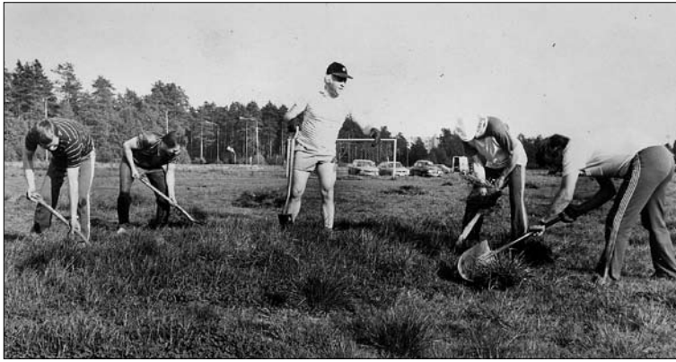
Turpeita poistettiin raviradan kentältä pelkällä ihmistyövoimalla. Kenttäalue saatiin kaupungilta 1958.
